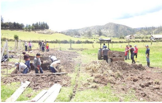
Construcción de estercolero
